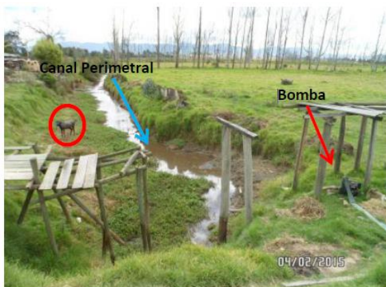
Fotografía No. 19. Estación de bombeo canal Perimetral
