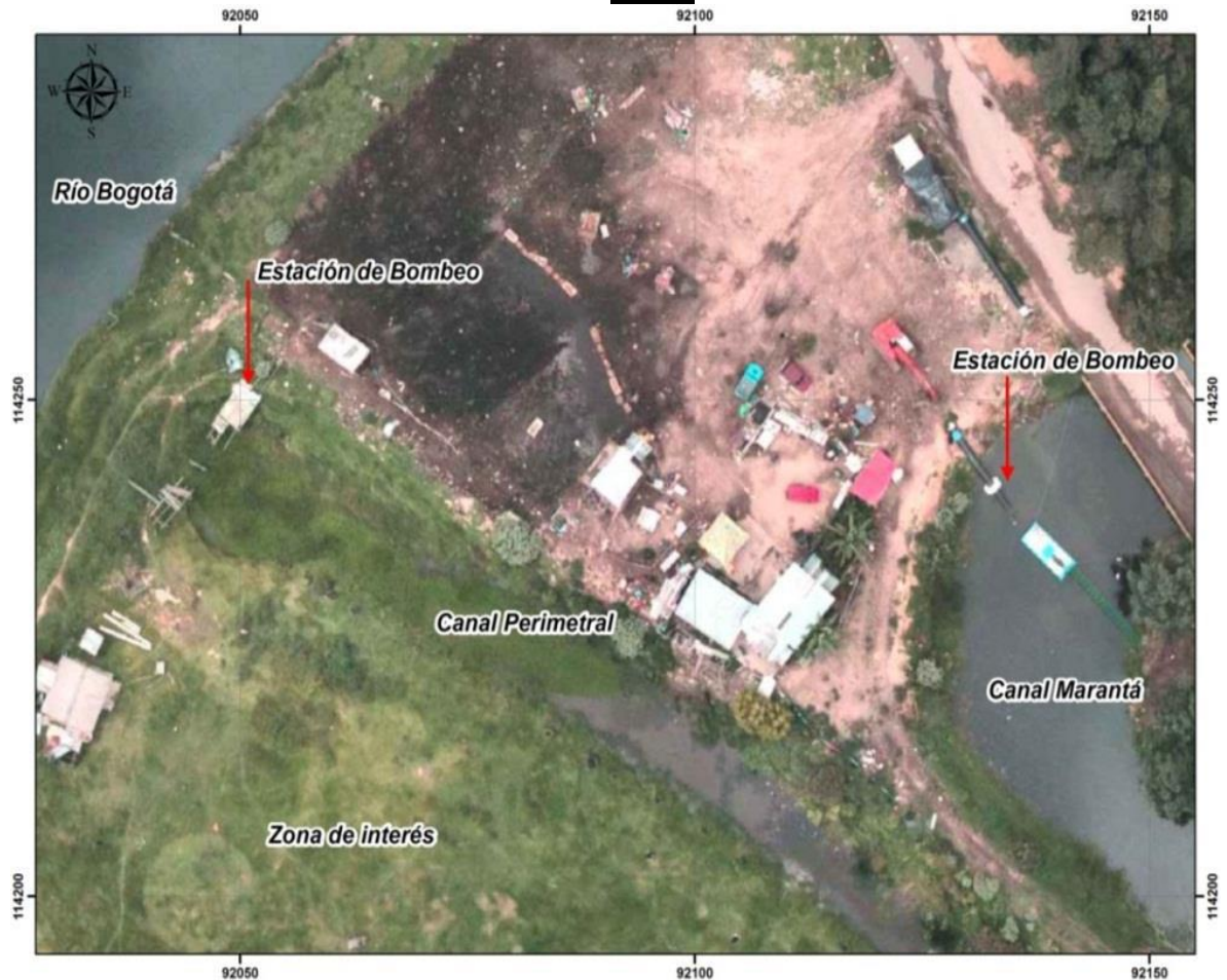
Imagen No. 15. Estaciones de bombeo del canal Marantá y canal perimetral
