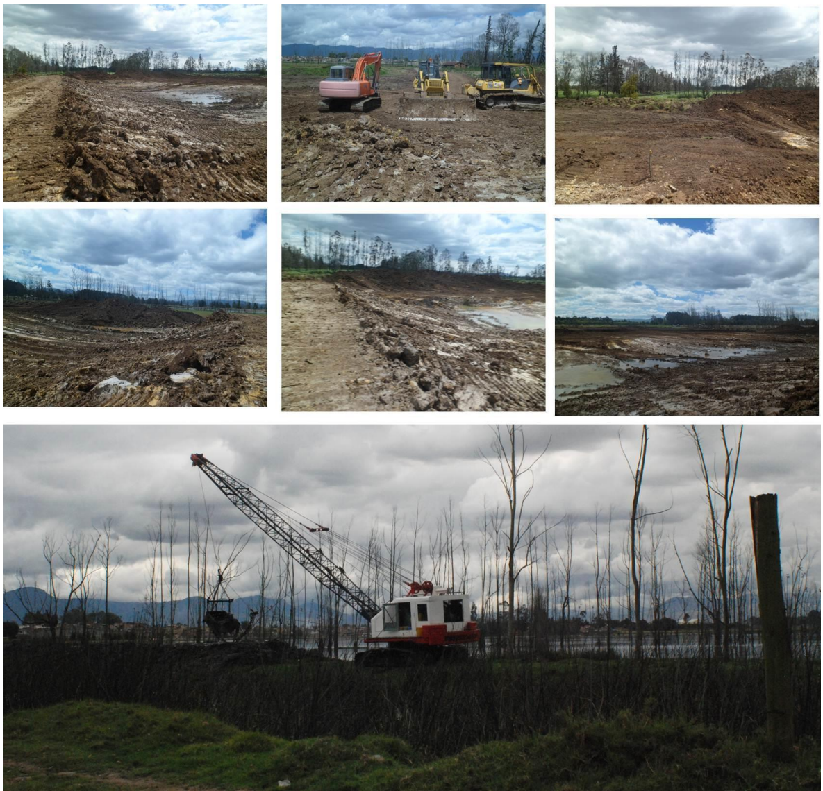
Fotografías 6, 7, 8, 9, 10, 11, 12. Movimiento de tierras y construcción de un jarillón a 270m de la margen izquierda del río Bogotá entre los meses de mayo y julio de 2012.
