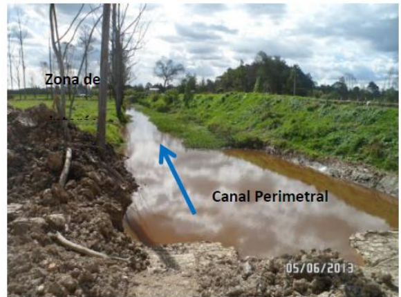
Fotografía No. 14. Canal perimetral del área de interés
