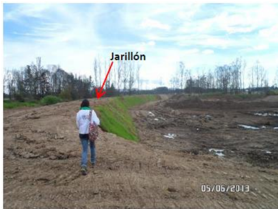
Fotografía No. 17. Jarillón construido al interior del área de interés
