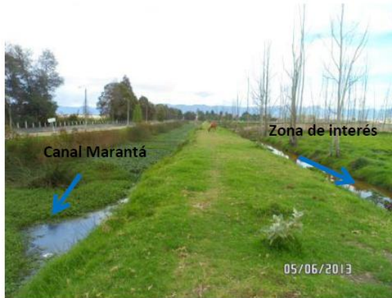
Fotografía No. 13. Niveles de los Canales Marantá y perimetral del área de interés
